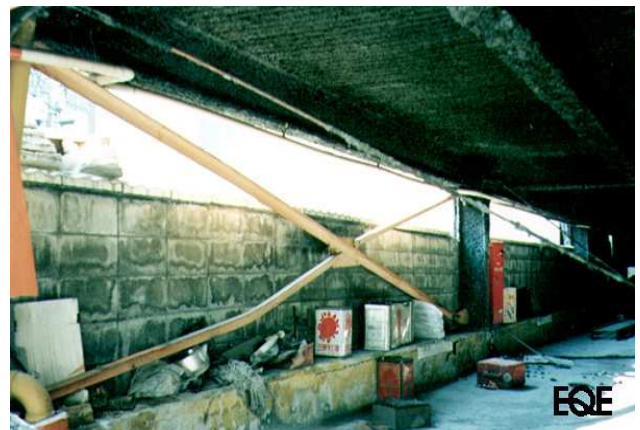
Figure 6-32 : Kobé 1995 – Instabilité des diagonales de contreventement.
