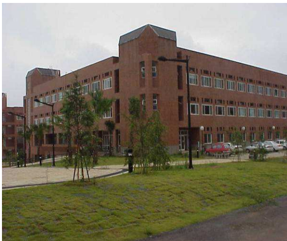
Figure 6-18 : Chi-Chi 1999 - Bâtiment contreventé par des voiles et parement extérieur en maçonnerie.
