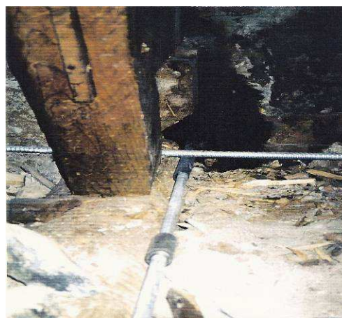
Figure 6-49 : Vue d'un croisement de tirants sous plancher
