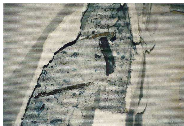
Figure 6-5 : Epagny 1996 – Bâtiment d'habitation R+7. La présence d'un local en maçonnerie au rez-de-chaussée crée un fonctionnement en poteau court d'un poteau de rive endommagé par éclatement du parement et flambement des armatures.
