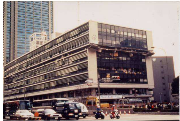
Figure 6-3 : Kobé 1999 – Mairie, rupture du 6 ème niveau
