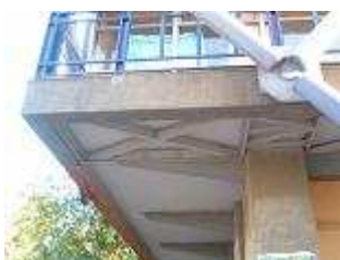
Figure 6-47 : Mise en place d'un treillis métallique sur toute la périphérie avec renforcement des diaphragmes horizontaux
