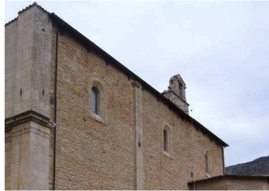
Figure 6-52 : On distingue les ancrages des lits de tirants transversaux et longitudinaux
