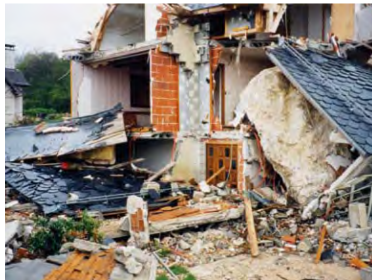
Maison sinistrée par la chute d'un bloc.
